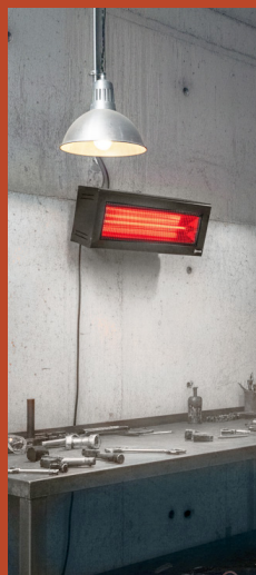
Installazione a muro
